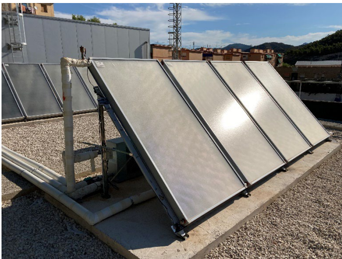
Colectores solares térmicos
