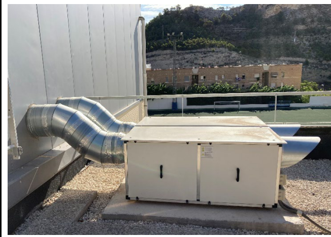
Recuperador de calor
