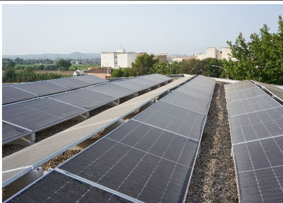
Instalación fotovoltaica en cubierta
