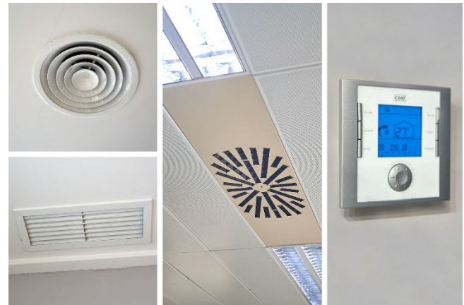
Sistema de distribución y control
