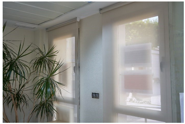
Estores enrollables en hall
