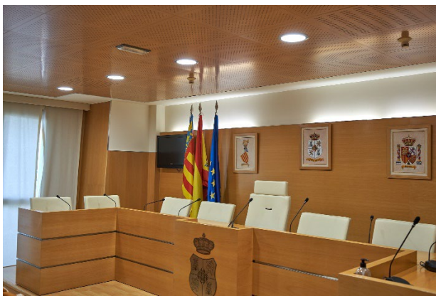
Downlights y tubos LED en salón de plenos
