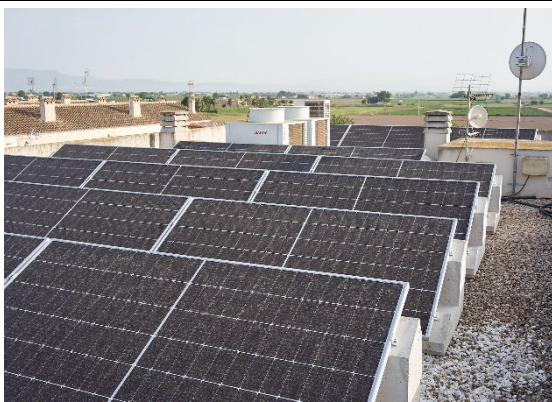
Instalación fotovoltaica en cubierta
