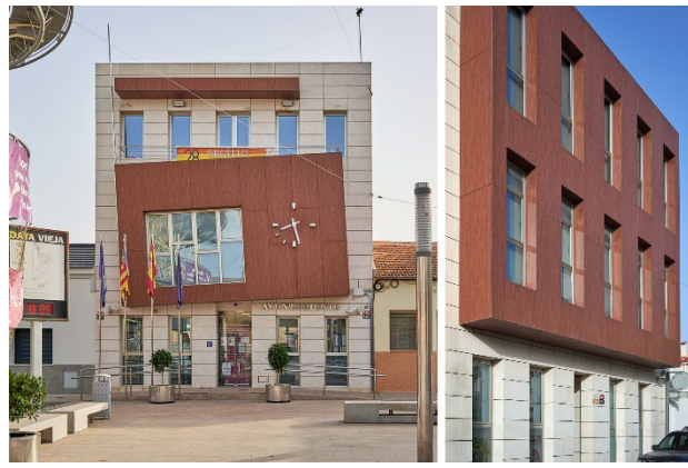
Huecos en fachada principal y trasera
