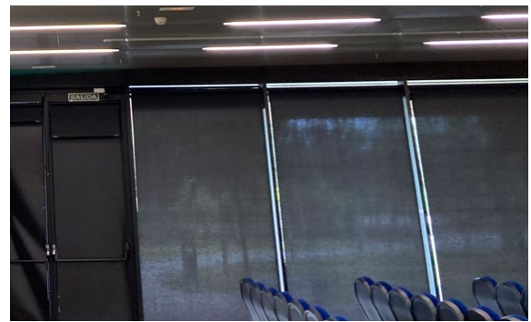
Huecos en salón de grados
