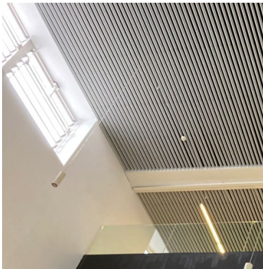
Huecos en despacho de planta primera
